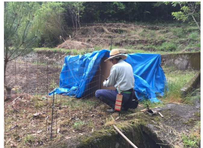
獣害ネット設置完了（圃場-B）
